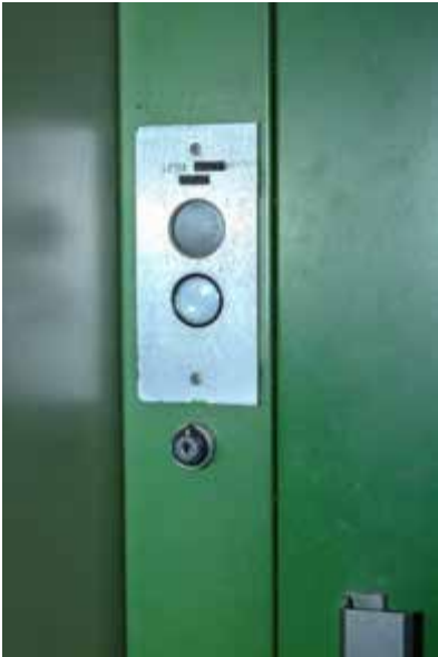
Figuur 42: Voorbeeld van toegangsbeperking tot liftschacht (liftdeur op slot)
