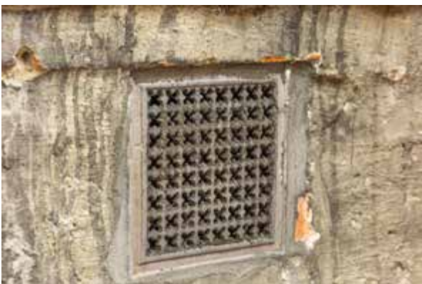
Figuur 34: Rooster an sich is relatief stevig vastgeklemd en hoeft niet te worden gedemonteerd, maar ruimte achter de gaatjes is (met zaklamp) soms in bepaalde mate vast te stellen (bv. leiding in asbest)
