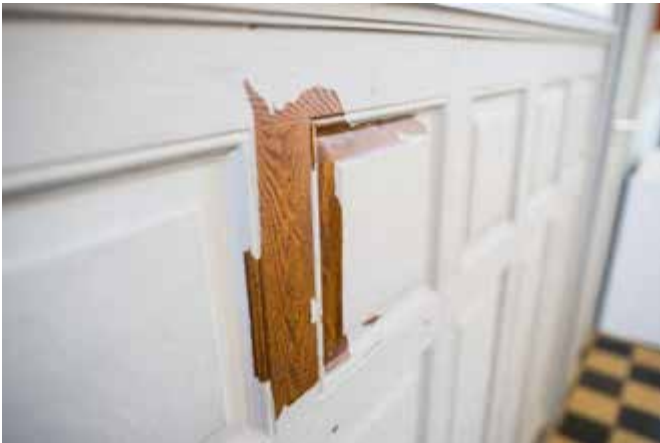
Figuur 72: Voorbeeld van lambrisering in vezelcement met uitzicht van hout
