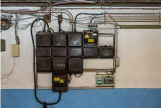
Figuur 11: Voorbeeld van bakelieten elektriciteitskasten
