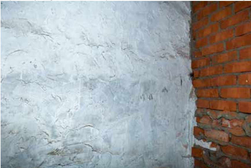
Figuur 52: Voorbeeld van pleisterwerk (overzichtsfoto)
