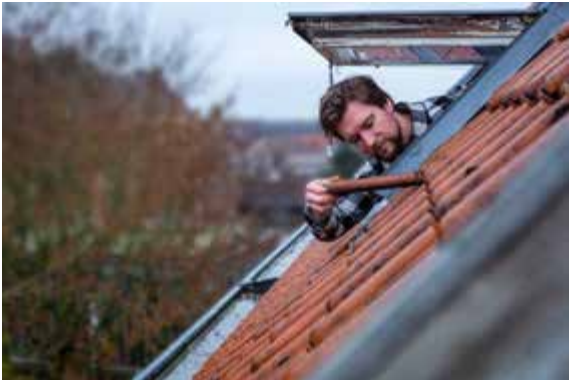
Figuur 30: Voorbeeld van opheffen van een dakpan
