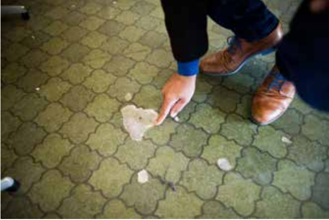
Figuur 26: Voorbeeld van vinylvloer met onderlaag in asbestkarton
