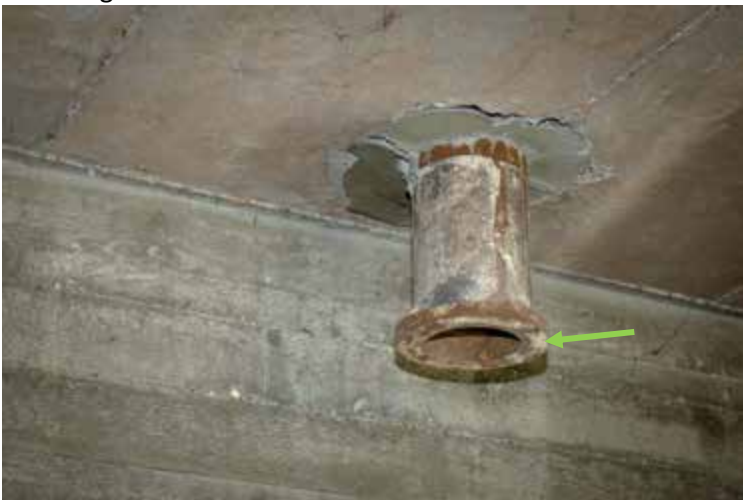
Figuur 50: Voorbeeld van beige resten van een flensdichting type "Klingerit"
