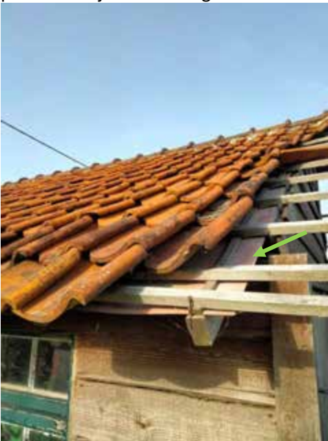
Figuur 7: Voorbeeld van niet-eenvoudig bereikbare onderdakplaten
