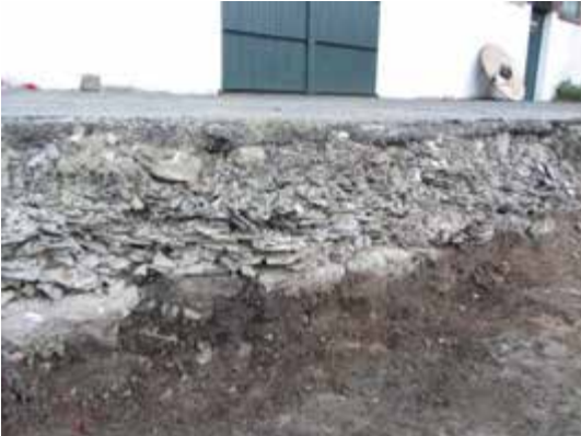
Figuur 33: Voorbeeld van een normaliter niet-waarneembare ophooglaag met stukken in vezelcement. Wel waarneembaar indien bestaande opening.
