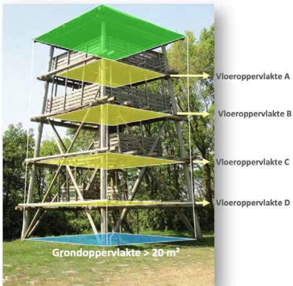
Figuur 19: grondoppervlakte van een toren
