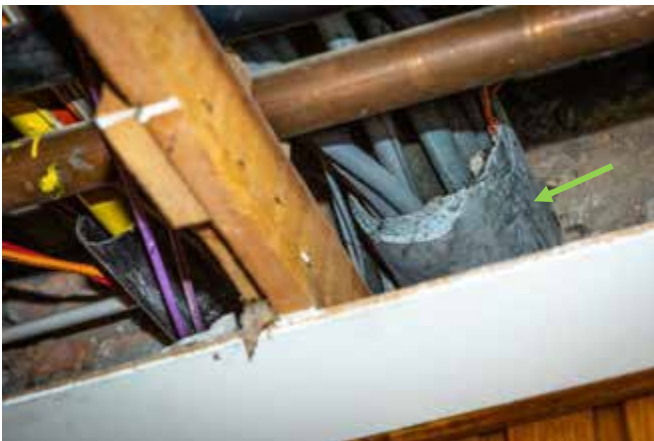
Figuur 10: Voorbeeld van een doorvoerbuis voor kabels
