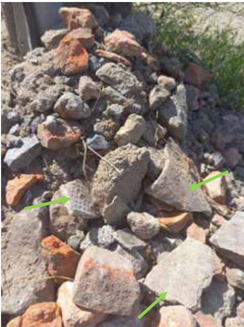
Figuur 5: Voorbeeld van opliggende resten in vezelcement op steenpuinlaag
