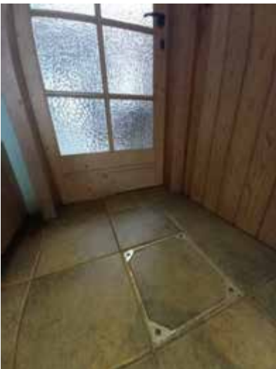
Figuur 31: Voorbeeld van niet-waarneembare ruimte onder vastgeschroefd putzdeksel
